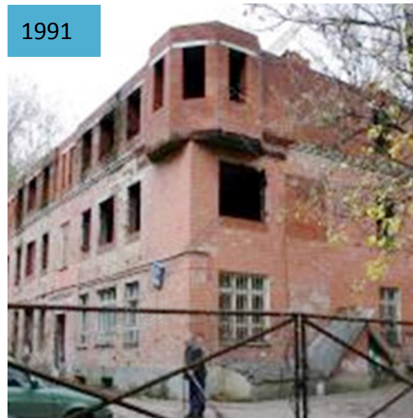
1991 Создание поликлиники и переезд в здание по адресу: Мосфильмовская, д. 31А
