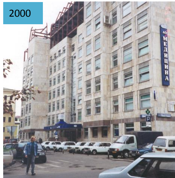
Завершение строительства трехэтажной надстройки здания клиники
